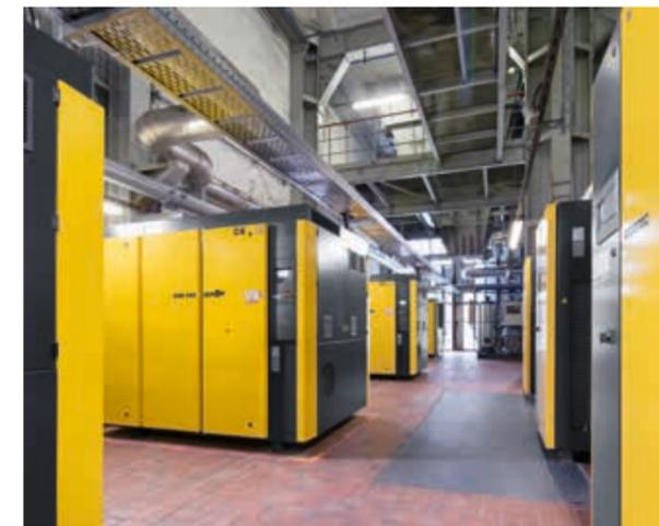
A central de ar comprimido funciona com um total de quatro compressores de parafuso, com o economizador de energia SIGMA PROFIL e motores de arranque IE4.
