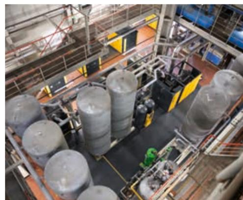
Dois sistemas de tratamento de ar comprimido diferentes, secam ar comprimido para o respetivo consumo.
