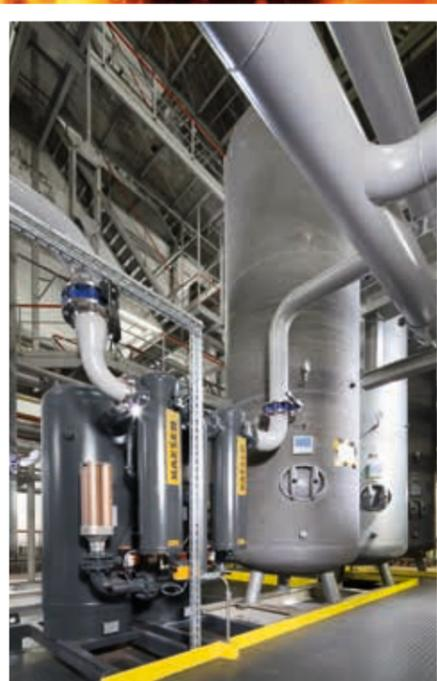
O volume de armazenamento de 70 000 litros divide-se por oito reservatórios de ar comprimido.
