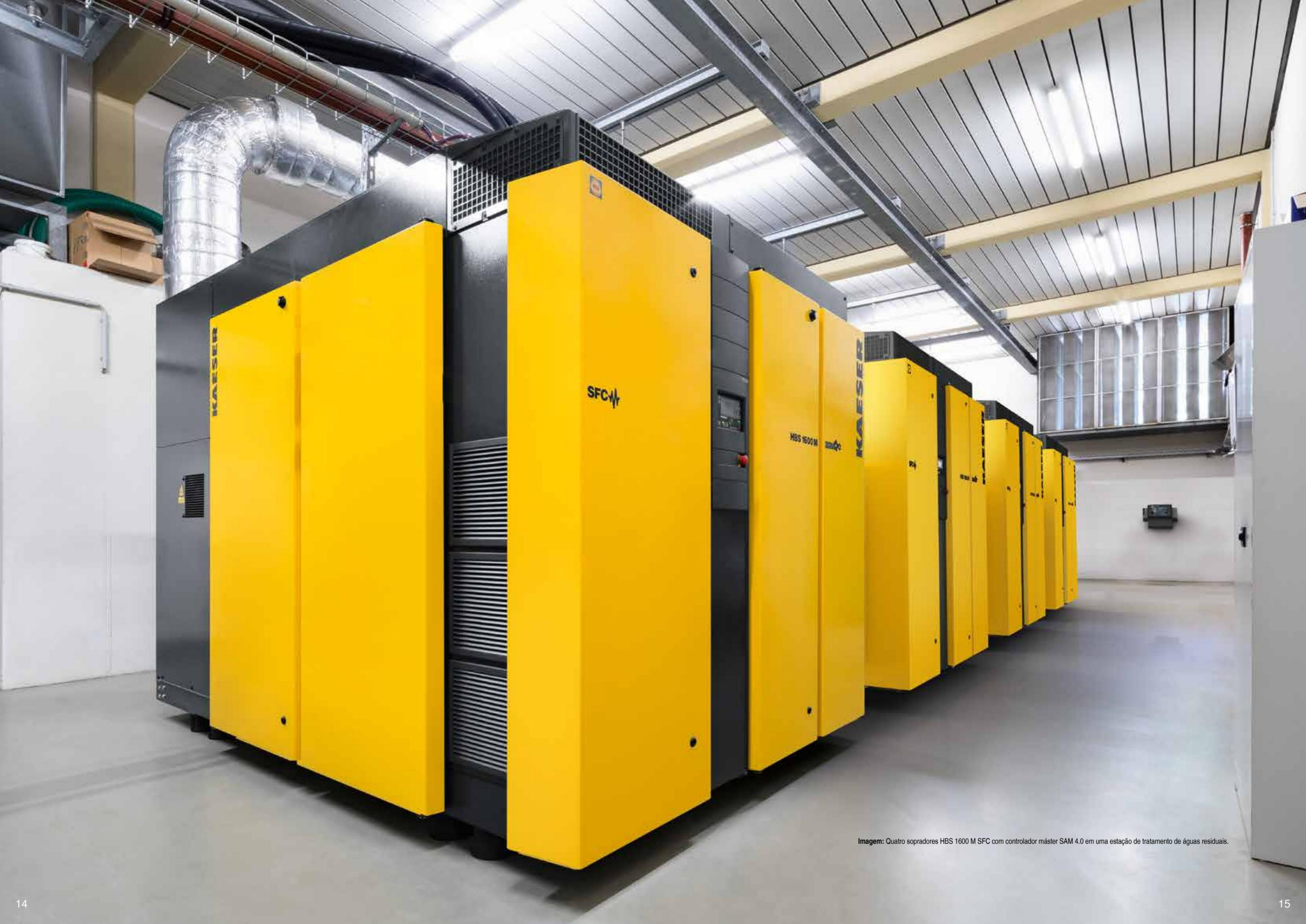
Imagem: Quatro sopradores HBS 1600 M SFC com controlador máster SAM 4.0 em uma estação de tratamento de águas residuais.
